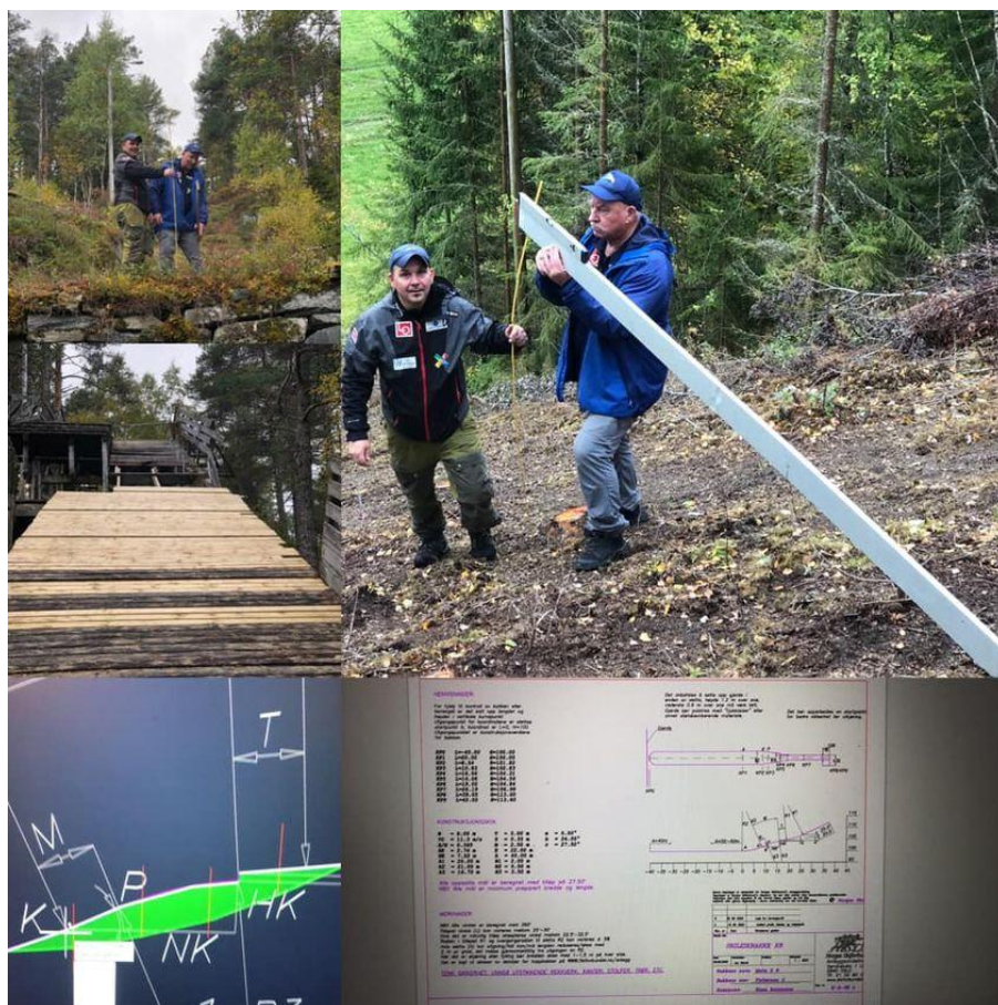
2 REHABILITERING AV HOPPBASSE. FOTO: J.AAS
