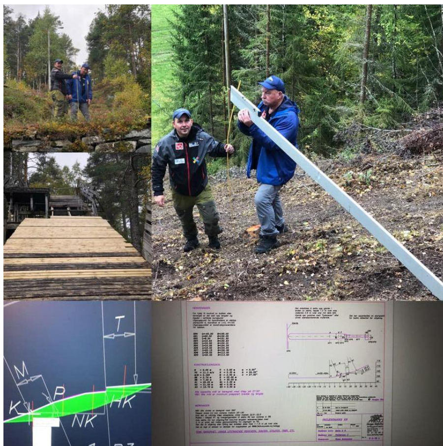
2 REHABILITERING AV HOPPBASSE. FOTO: J.AAS
