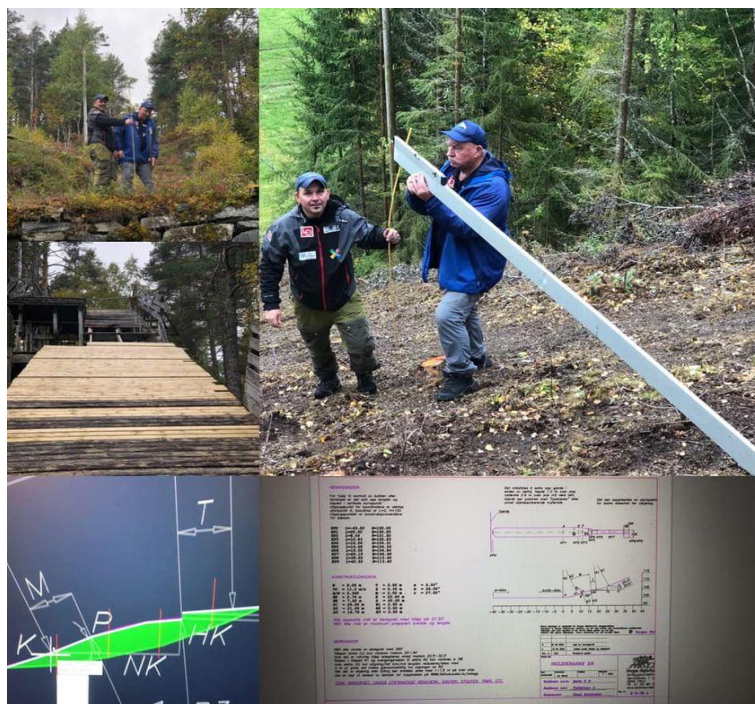
3 REHABILITERING AV HOPPBASSE. FOTO: J.AAS
