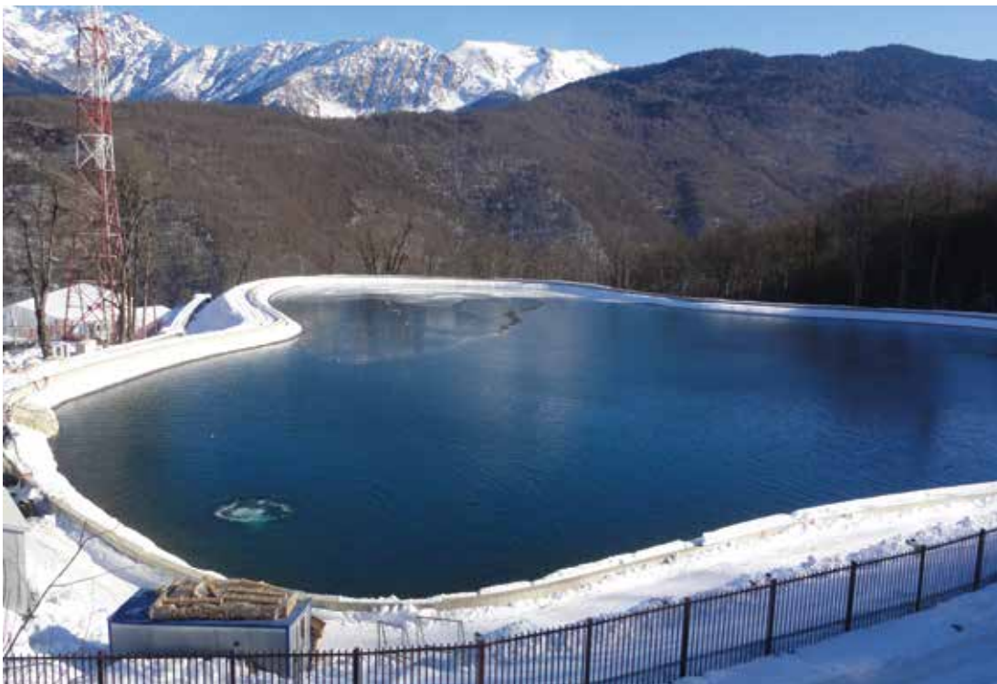
Kunstig anlagt vannmagasin som sikrer tilstrekkelig vann til snøproduksjon over korte perioder. Kan også være et miljøskapende element om sommeren.
