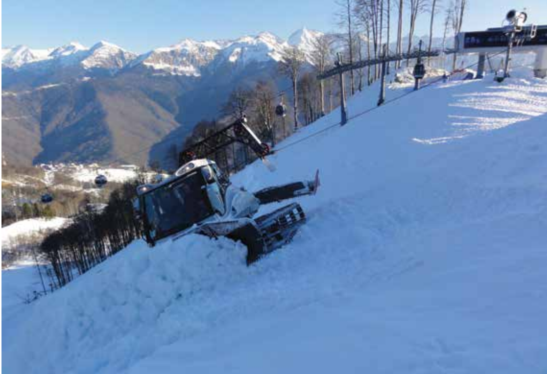
Vinsjemaskin i arbeid i brattheng flytter snø sideveis i nedfarten.
